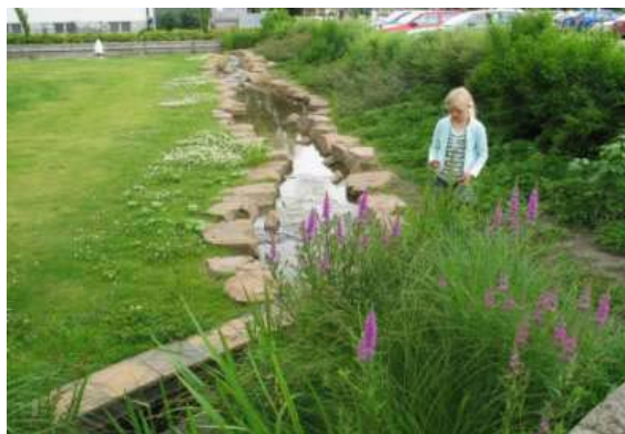
Eksempel på regnvandsafledning via en åben grøft.
