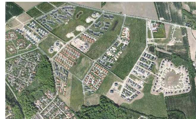
Inspiration fra Kolding: Der er skabt stor variation i arkitekturen fra boligvej til boligvej i området. Dette er sikret gennem klare lokalplanbestemmelser.
