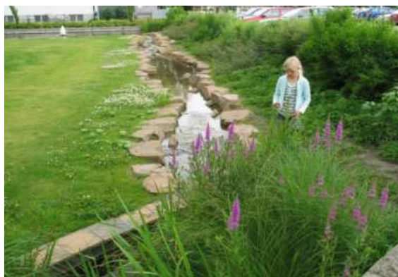
Eksempel på regnvandsafledning via en åben grøft.
